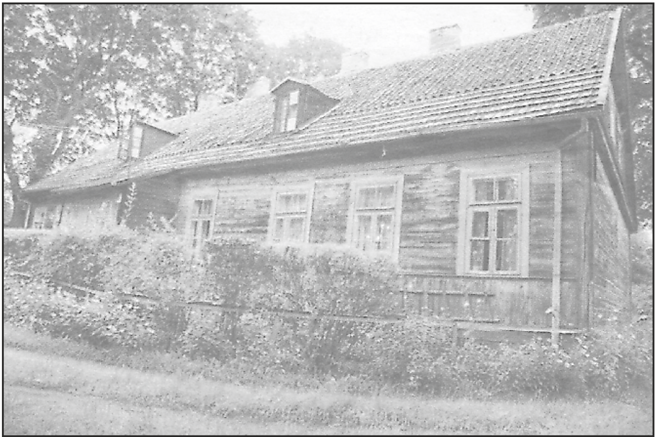
budynek przy ulicy Staszica 6c
