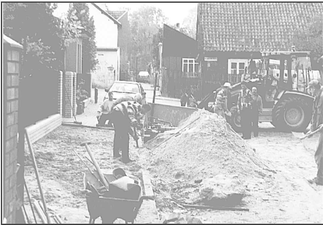
Prace przy budowie nawierzchni ul. Wiktorii
